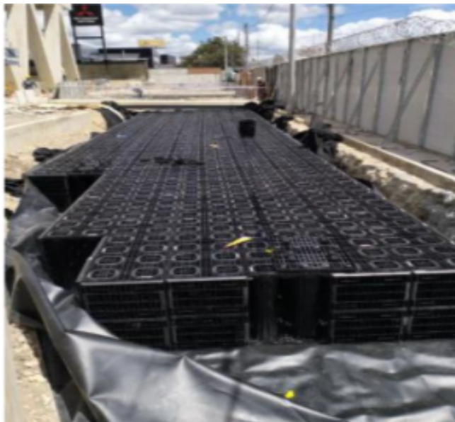
Fotografía. Instalación del Tanque de Tormenta – Campus Av. 68
